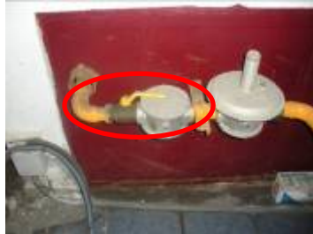
Llave de corte en sala de calderas
